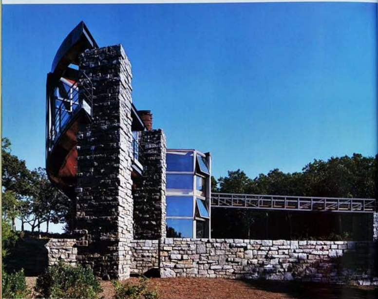
Der Steg verbindet den Haupteingang des Ferienhauses mit dem selbstständigen Bauvolumen der Garage und überwindet gleichzeitig verschiedene Geländehöhen.
